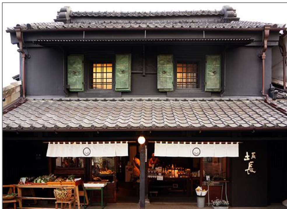
図表 1-1-1 お休み処坂長の外観（HP より）
